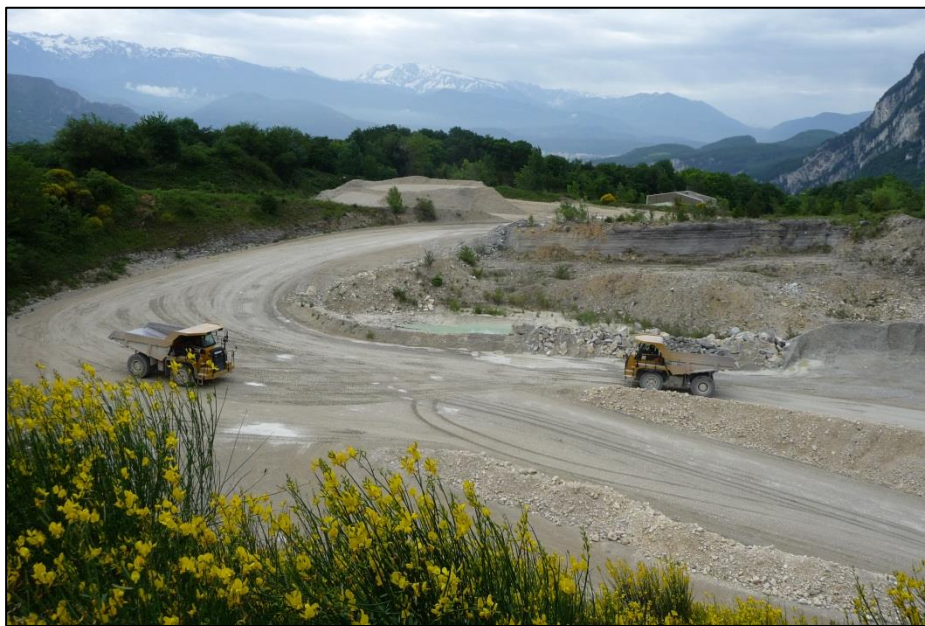
Photo 6 : Transfert des matériaux depuis la zone d'extraction à l'installation de traitement
