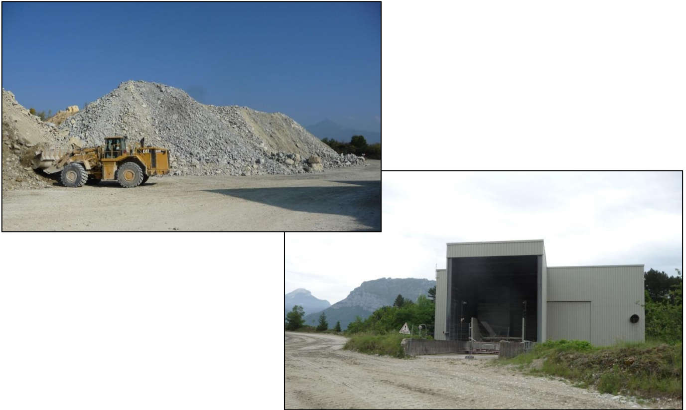
Photo 7 : Reprise des matériaux depuis la zone de stock pour alimenter la trémie du concasseur
